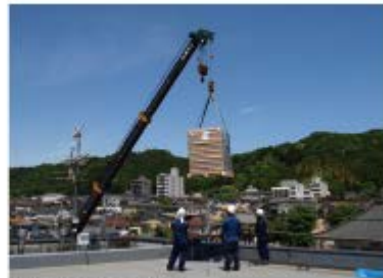
たまでん13号発電所
