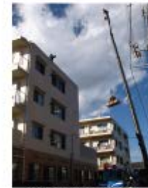
たまでん2号発電所
