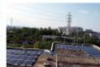
たまでん6号発電所
